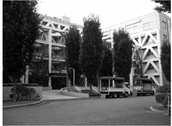
【図版No. 40】 現在の本庁舎東側 (第二期工事部分)
