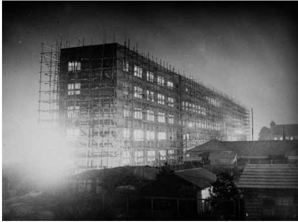
【図版No. 34】昼夜兼行で行われた第一期工事 (埼玉新聞社戦後報道写真 S260852 - 01)
