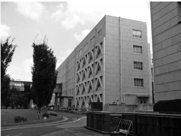
【図版No. 41】 現在の本庁舎北側 (第三期工事部分)
