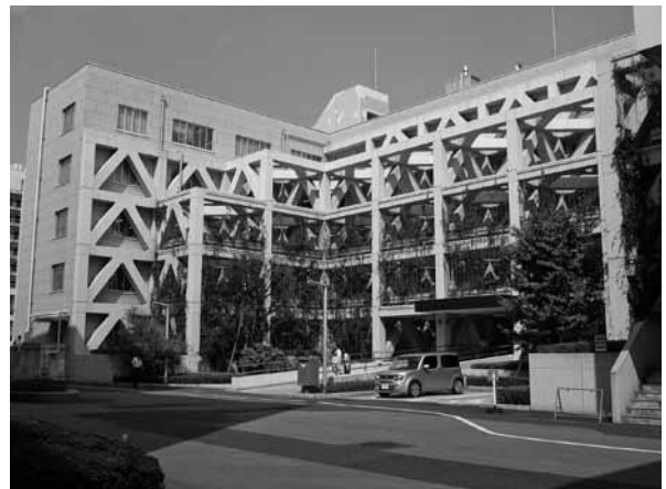
【図版No. 42】 現在の本庁舎西側 (第四期工事部分)
