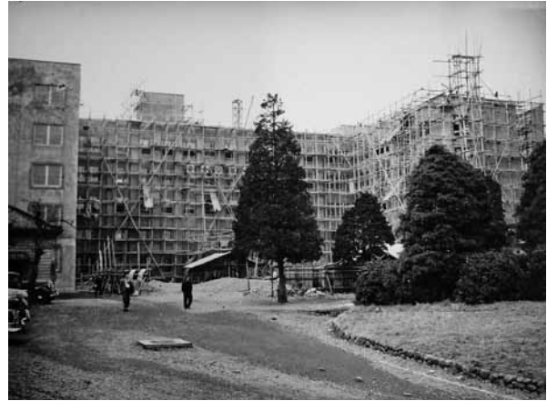
【図版No. 35】完成間近の第二期工事 (埼玉新聞社戦後報道写真 S271183 - 02)
