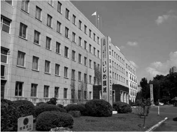
【図版No. 39】 現在の本庁舎南側 (第一期工事部分)
