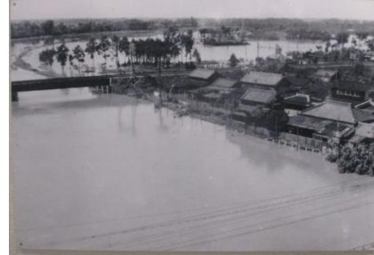
S220003 冠水が続く大沢町
