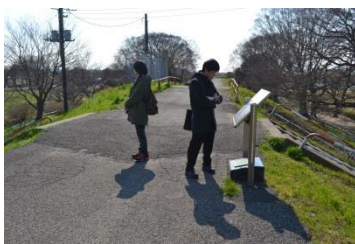
土木遺産 美谷本2横堤
