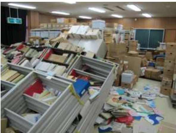
書架の倒壊（幸手市 平成23年）
