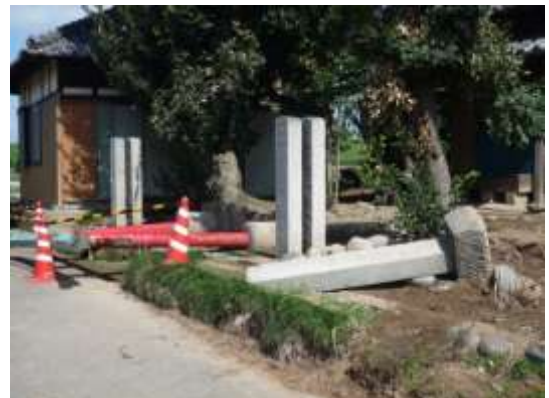
白髭神社の被害状況（熊谷市）
