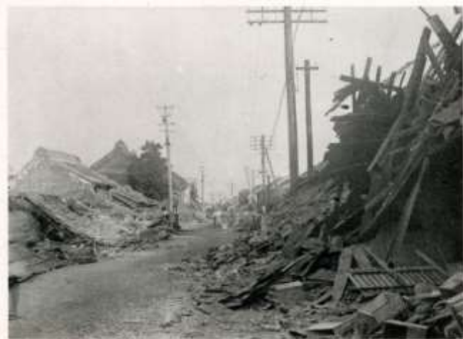
関東大震災による被害
