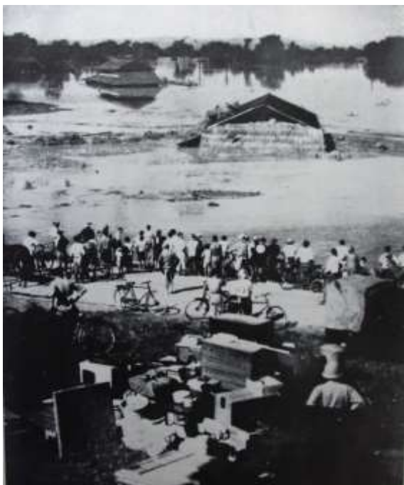
カスリーン台風による被害（幸手市） （『埼玉県水害誌』より転載）
